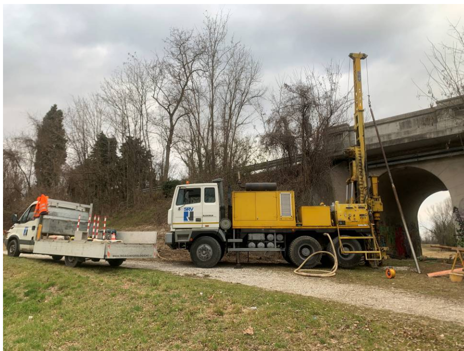
Foto n° 1: Sondaggio S1: sonda autocarrata modello "NENZI GELMA2".
